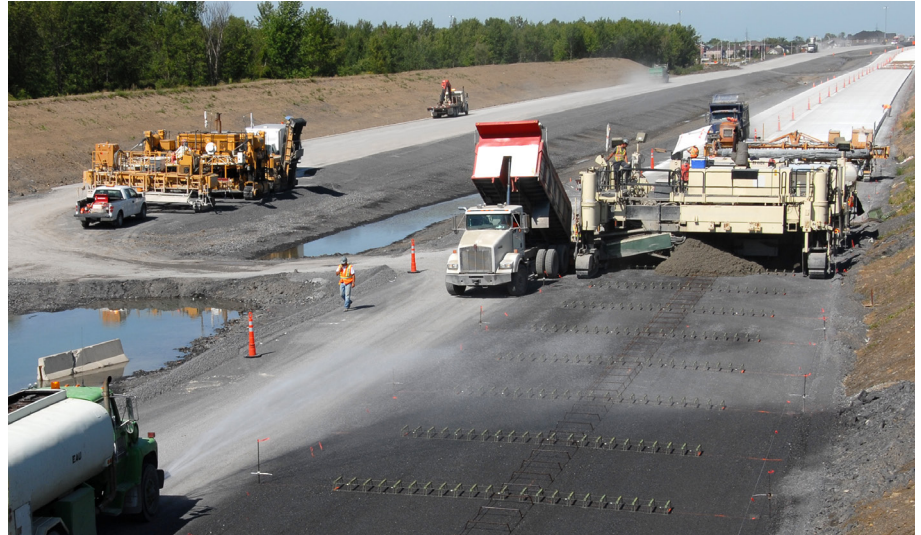
Figure 4 – Chaussée en béton avec tirants et goujons
