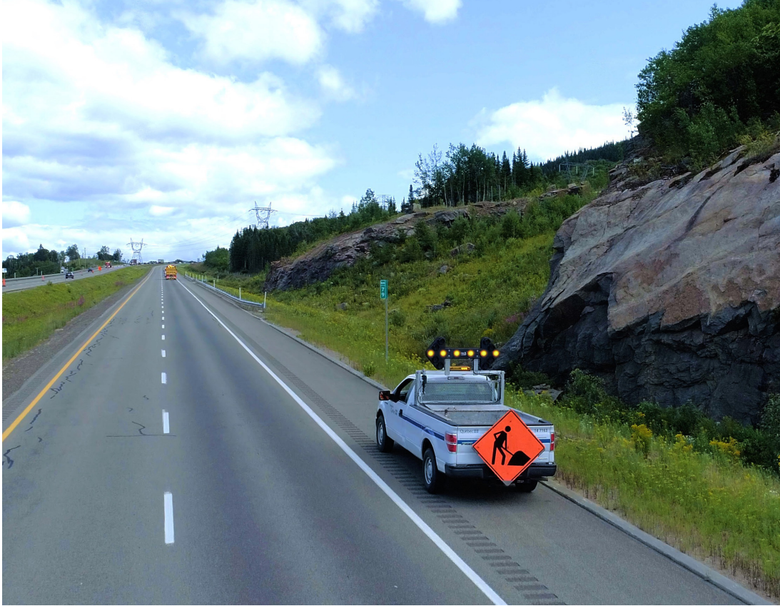
Figure 7 Signalisation d'avertissement placée sur un véhicule d'accompagnement se trouvant dans l'accotement
