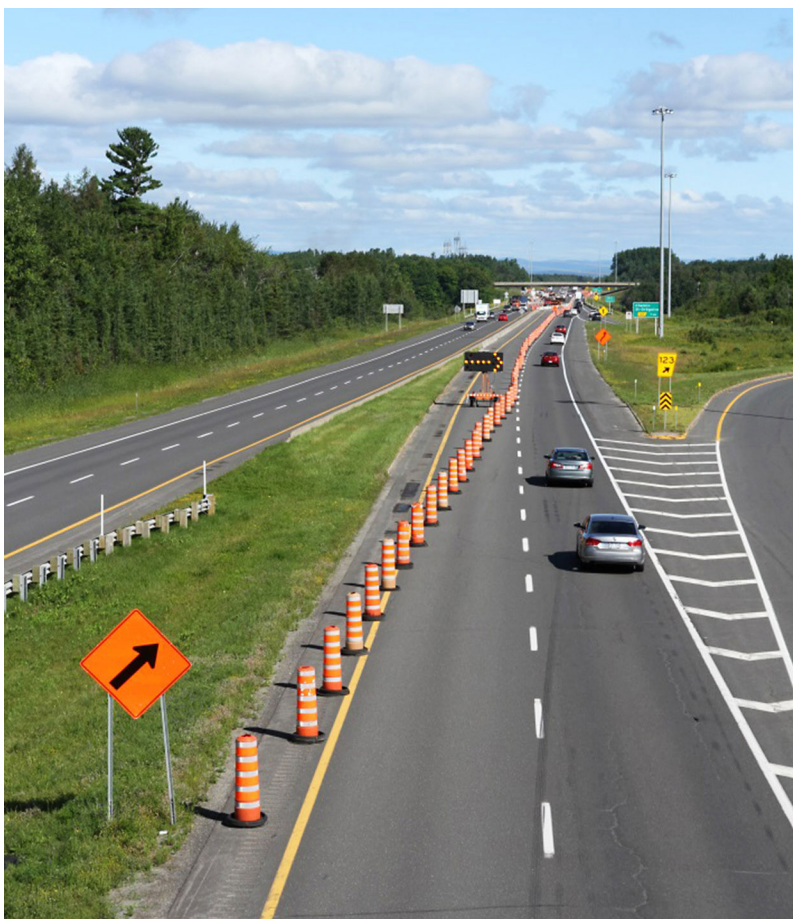
Figure 2 Utilisation d'un dispositif de signalisation guidant les usagers et canalisant la circulation en dehors de l'aire de travail
