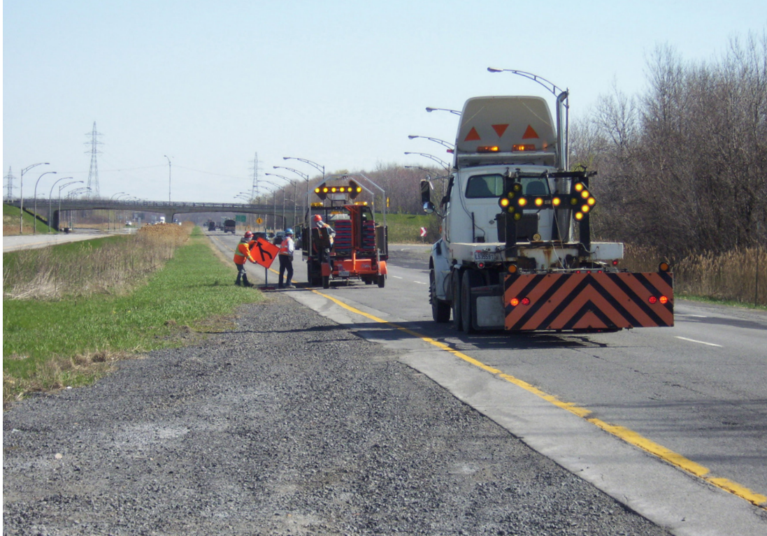
Figure 4 Utilisation d'un VP-AIFV pour sécuriser les travaux de mise en place de la signalisation temporaire
