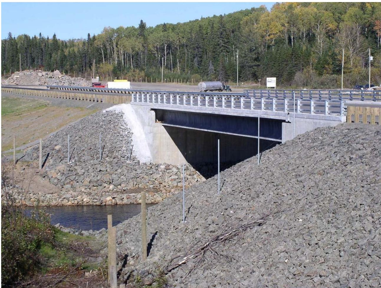
Exemple de structure de type « pont » que l'on retrouvera à certains endroits de la future route 138. Pont à poutres de béton.
