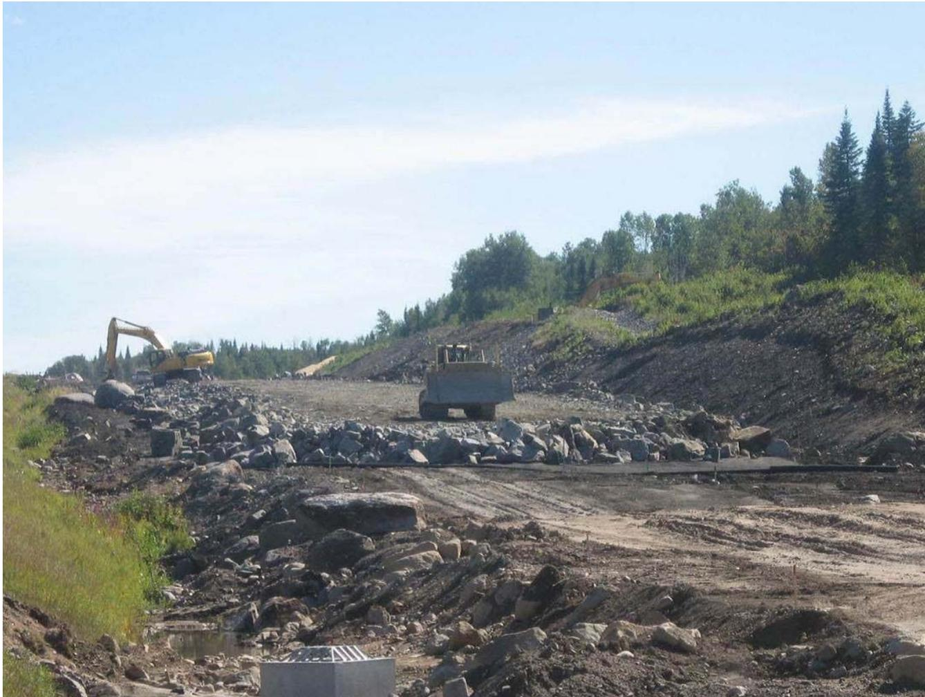
Les matériaux excavés sont utilisés pour construire le remblai de la nouvelle route. Ainsi se crée un équilibre entre les matériaux de remblai et de déblai.
