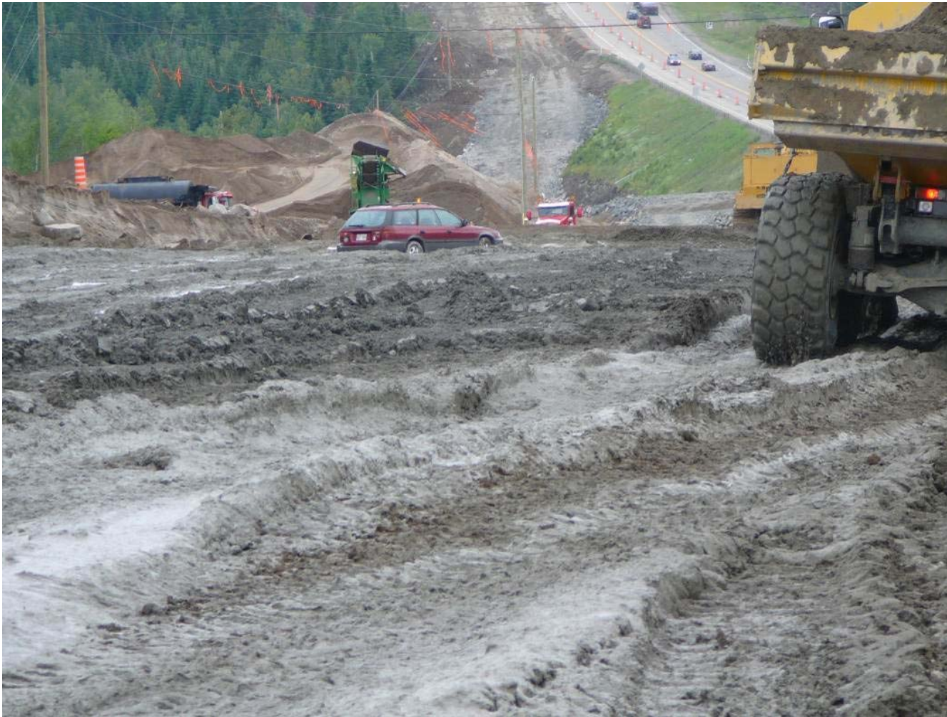
Exemple de sol à faible capacité portante.
