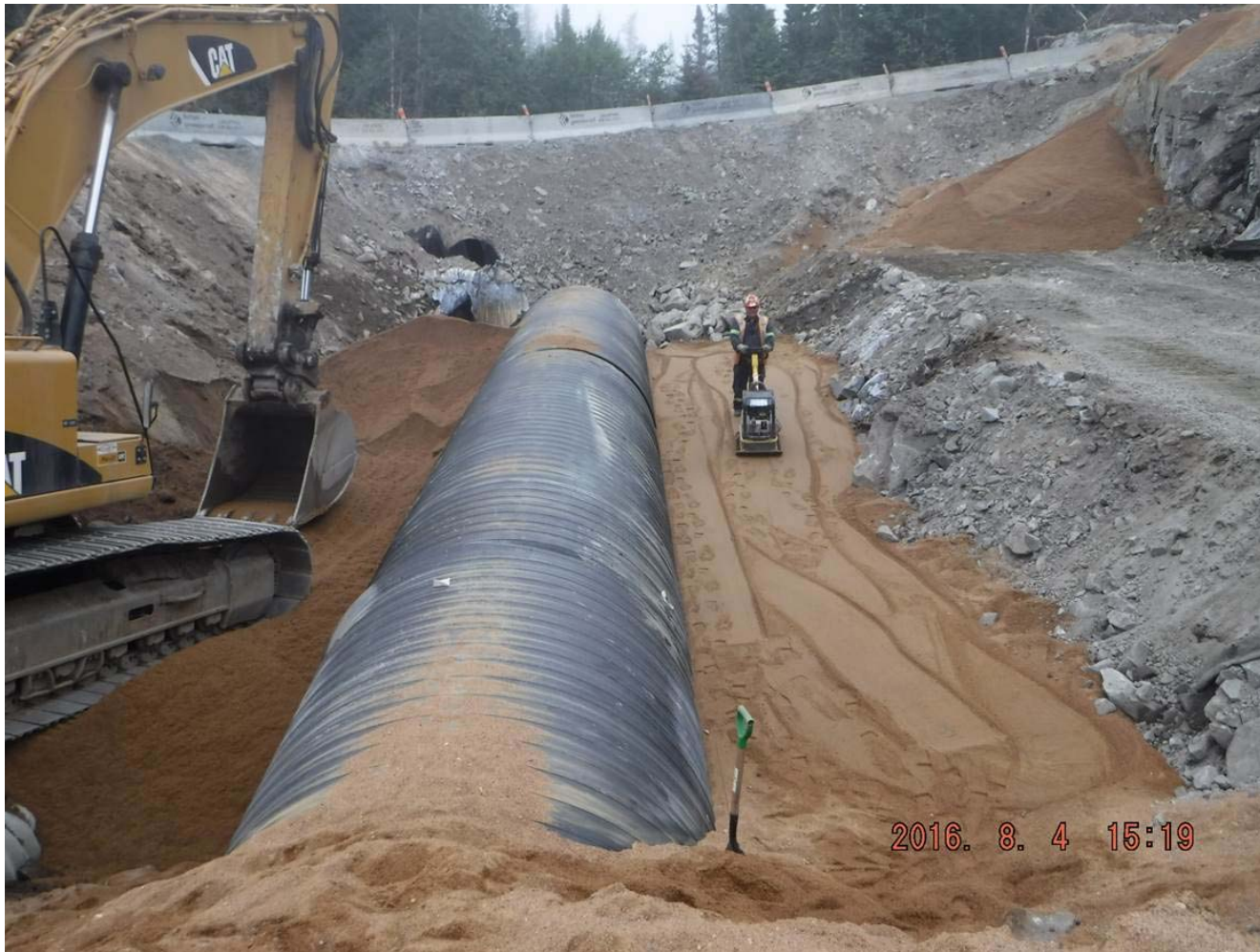
Installation d'un ponceau (1).
