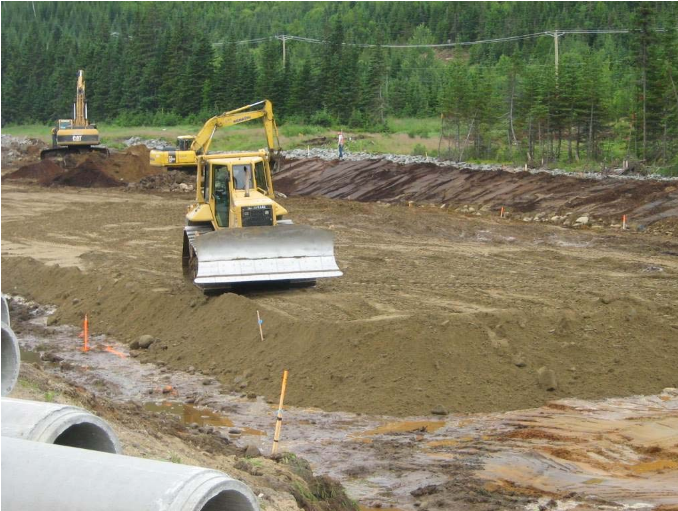
Remplissage avec du remblai.
