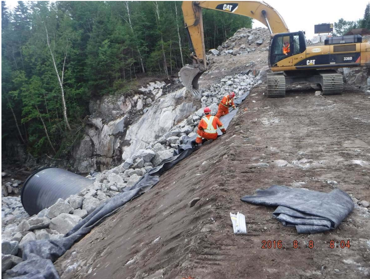
Installation d'un ponceau (2).
