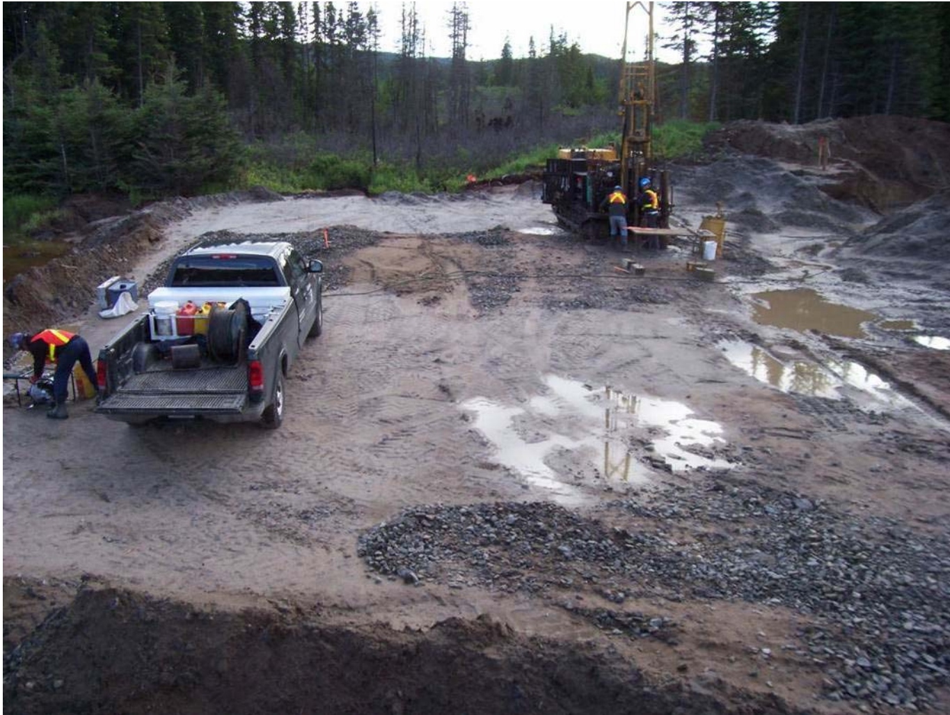
Fondations d'ouvrages d'art (pont-portique).
