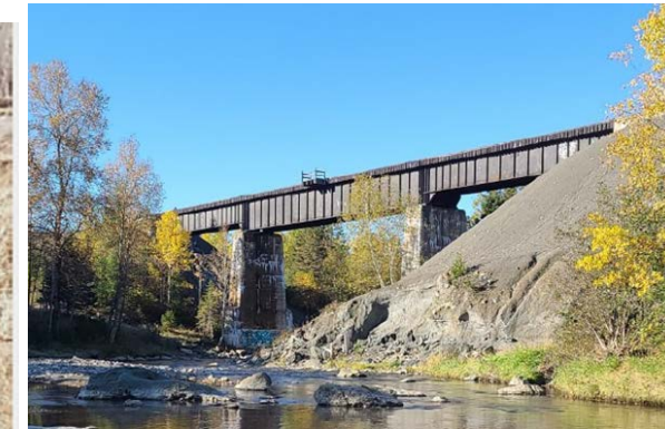
Au-dessus de la rivière Bécancour
