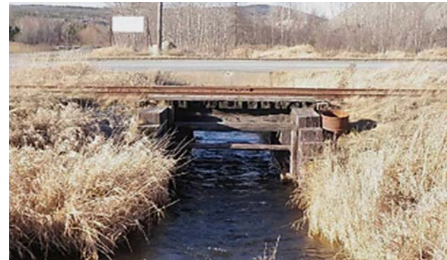
Au-dessus du ruisseau Lessard
