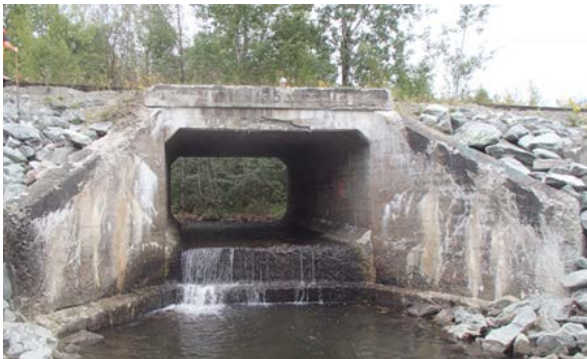
Au-dessus du ruisseau de l'Aqueduc
