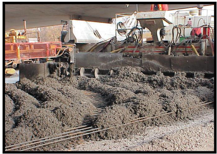
Figure 2 : Bétonnage de la dalle en BAC
