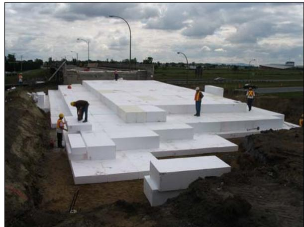
Figure 1 : Construction d'un remblai léger en polystyrène
