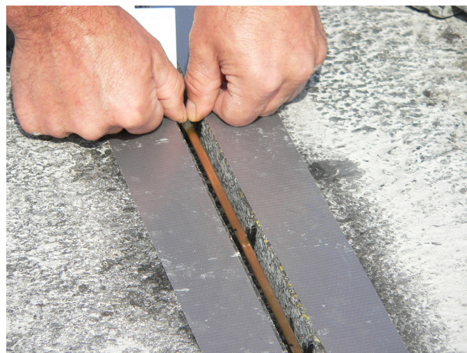
Figure 1 – Pose d'un capteur piézoélectrique
