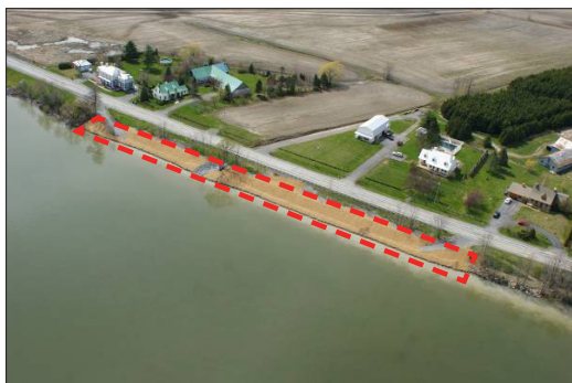
Figure 5 – Travaux de stabilisation d'un talus qui présentait des signes précurseurs de glissement de terrain
