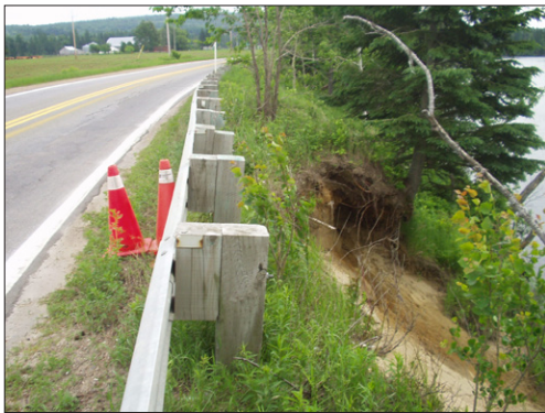
Figure 3 – Glissement de terrain survenu à proximité d'une route
