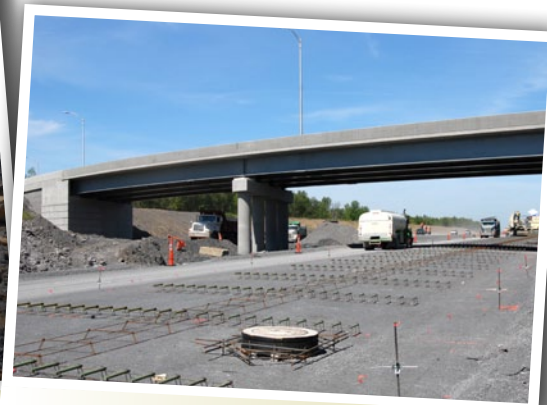
Construction de la dalle de béton du tronçon Jean-Leman
