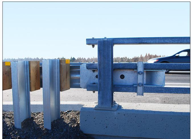
Photo 4 - Raccordement à une glissière de type 43 – vue arrière
