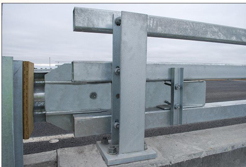
Photo 2 - Raccordement à une glissière de type 210 – vue arrière
