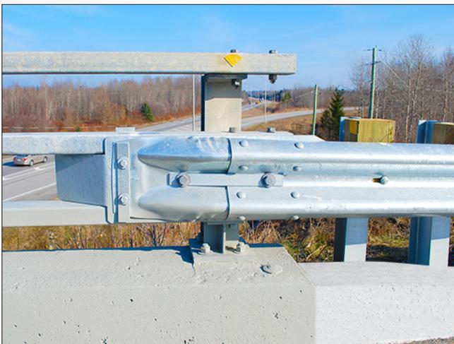
Photo 3 - Raccordement à une glissière de type 43 – vue avant
