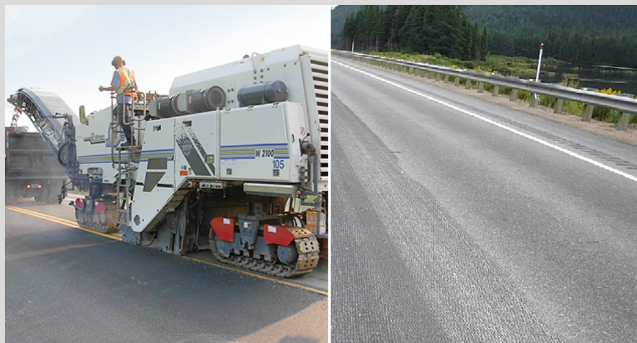
Figure 6 – Équipement de planage fin et chaussée après travaux correctifs.
