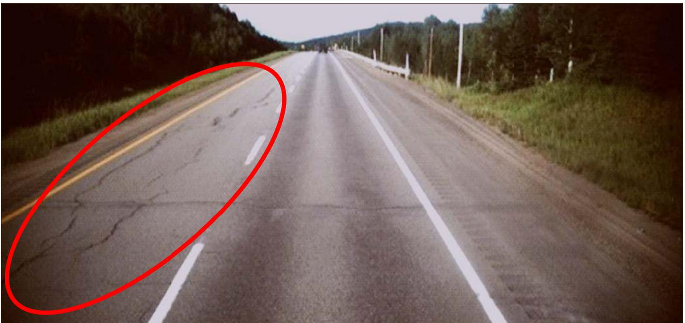
Figure 2 – Chaussée SANS infrastructure améliorée : route 175, fissuration prématurée
