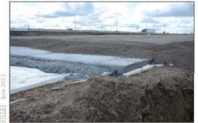
Figure n° 4 - Les couches de la structure de chaussée en déblai.
