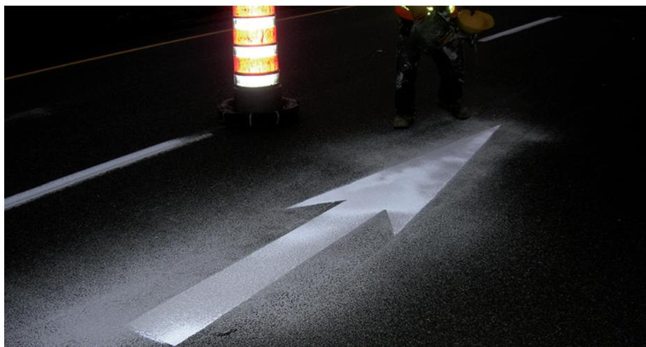
**Figure 20** Rétro réflexion problématique d'une flèche
