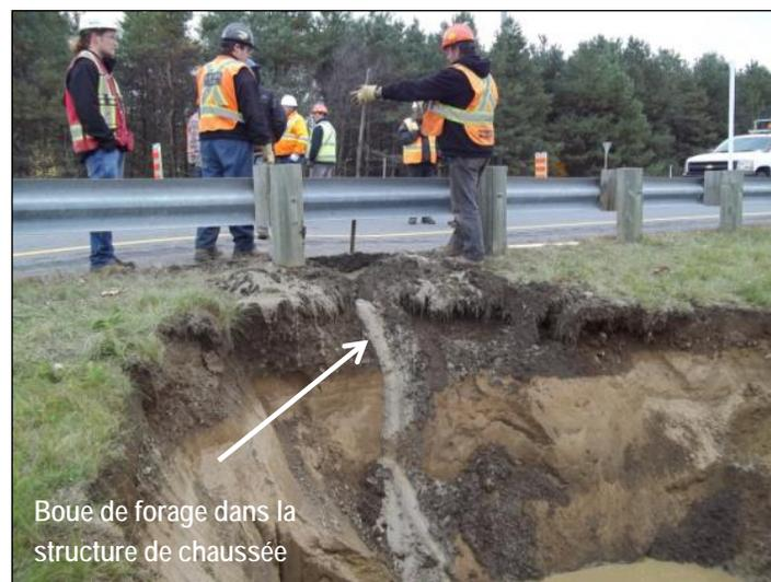
Figure 55 : Problème de contamination par des particules fines
