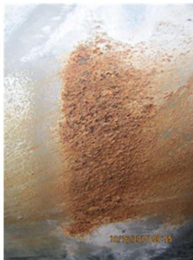
Figure 17. Surface galvanisée présentant de la rouille blanche de niveau avancé
