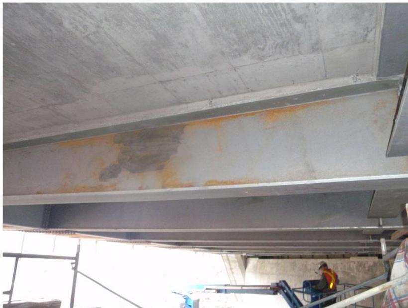
Figure 20. Contamination de la galvanisation
