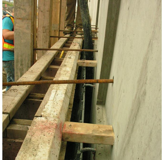
**Photo 3 : Haut de la glissière avec ouverture inférieure à 200 mm lors du bétonnage**
