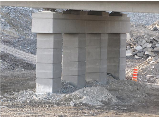
**Photo 2 : Pile centrale après bétonnage**
