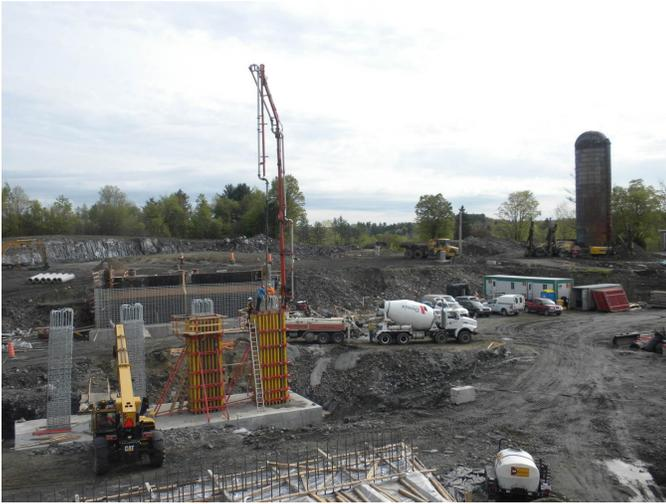
**Photo 1 : Bétonnage des colonnes de la pile centrale**
