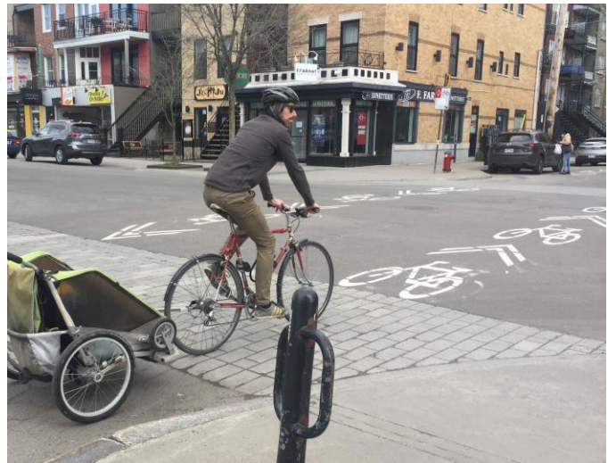
Figure 4 - Marquage destiné à indiquer la présence d'un aménagement cyclable et de cyclistes à une intersection
