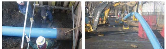
Le tuyau Brute Fusionnée DR25 a été choisi car il offrait des caractéristiques de débit optimales pour le gainage d'une conduite d'acier
