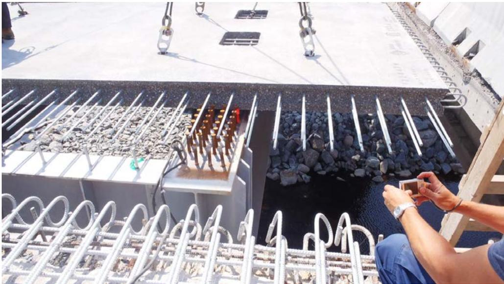
Figure 12 – Extrémités de dalle près des joints de dilatation
