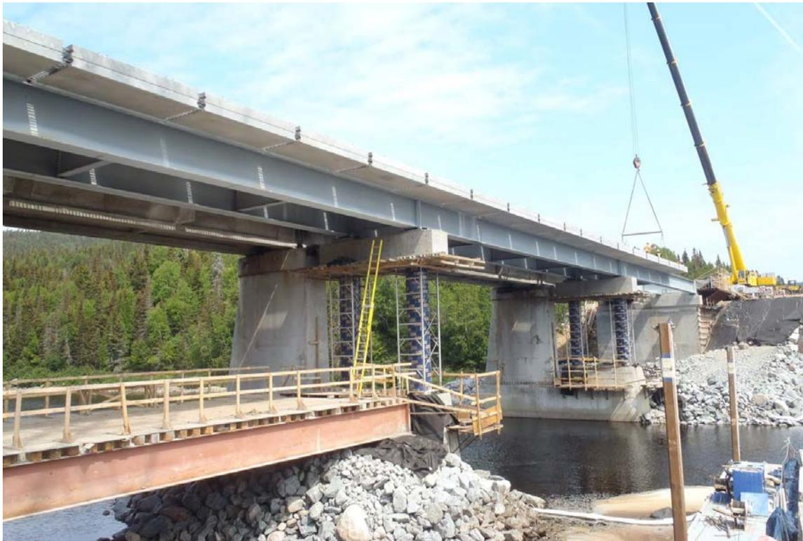
Figure 6 – Installation des dalles préfabriquées
