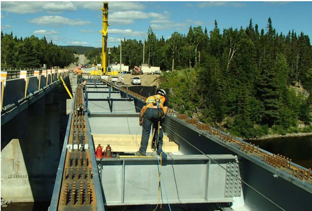
Figure 4 – Installation de la charpente métallique
