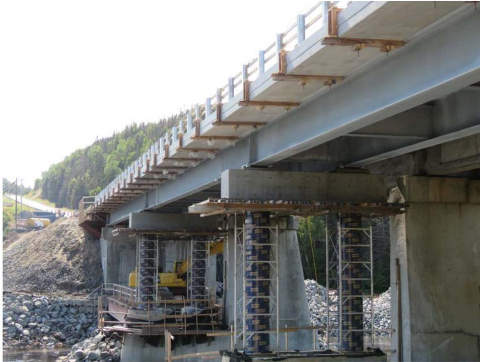
Figure 9 – Coffrage des joints
