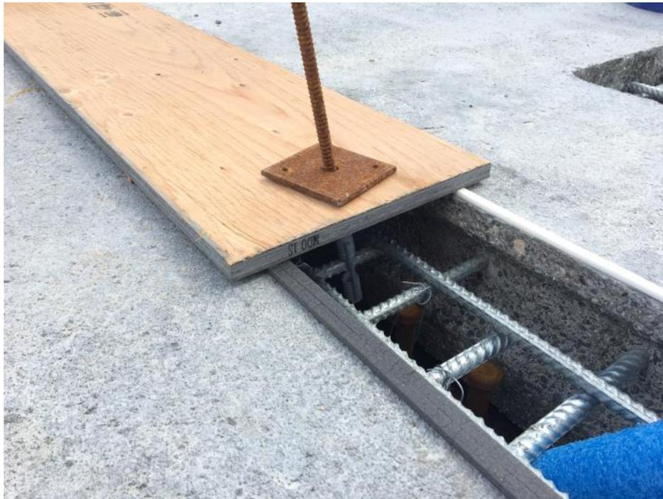
Figure 10 – Surépaisseur pour le coffrage des joints
