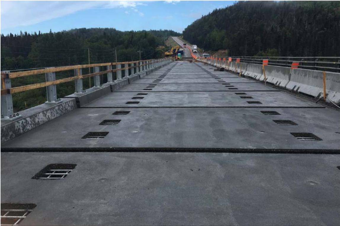
Figure 7 – Dalles préfabriquées installées
