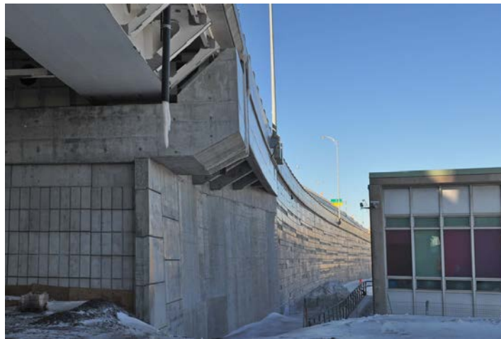
Figure 5 : Culée Gadbois partiellement terminée
