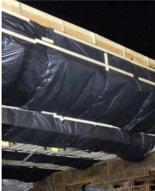
Figure 10 : Photographie de la protection par temps froid installée au pont Est
