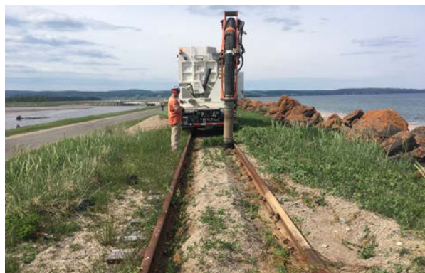
Le nettoyage de la voie ferrée à Coin-du-Banc. Un camion, qui aspire les tonnes de sable et de gravier accumulés, réussira à nettoyer cette section en 10 jours. Cela permettra d'entreprendre, ensuite, le changement de traverses.
