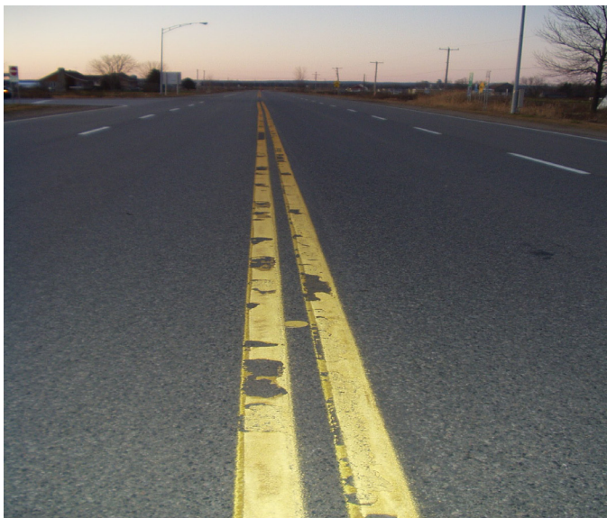
Figure 3 : Arrachement d'époxy appliqué sur un marquage à l'époxy (2 couches)
