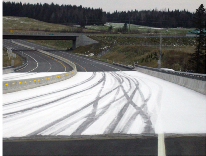
Figure 3 – Pont de la rivière Famine sur l'autoroute 73 à la suite de précipitations le 14 novembre 2013 (avant l'ouverture de la route, aucun entretien réalisé)
