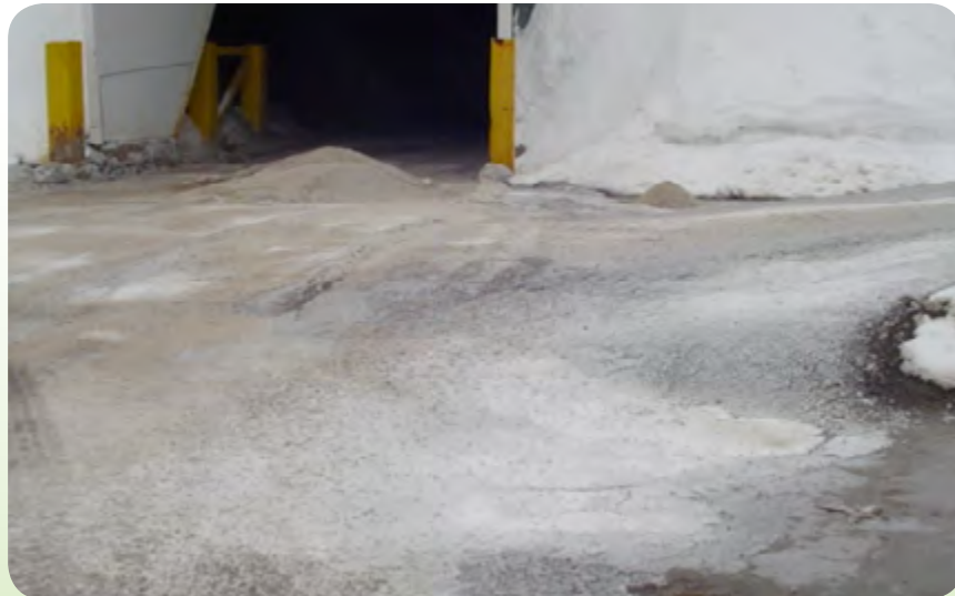
FIGURE 10 : Exemple d'une aire de manutention mal entretenue
