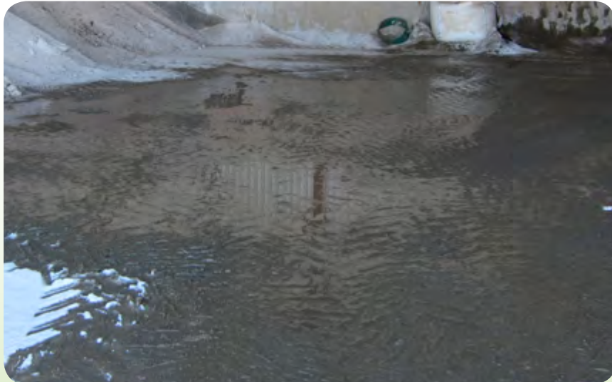
FIGURE 9 : Exemple d'un entreposage inadéquat des matériaux
