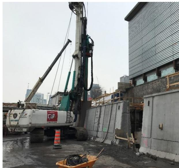
Figure 11 : Forage des pieux de la culée Nord à proximité de la station de métro Champ-de-Mars
