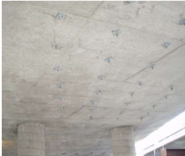
Figure 10 : Plaque d'ancrage visible - Tiré de Pilon (n.d.)
