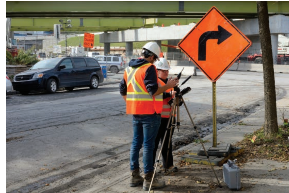
► L'équipe responsable d'assurer la qualité du milieu sillonne la zone du chantier. Elle procède ici à la prise d'un relevé sonore sur le terrain pour vérifier le niveau de bruit. (photo : Édith Martin)
