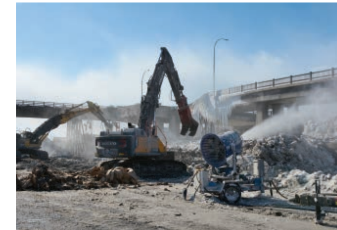
▼ Démantèlement de l'échangeur Angrignon durant l'hiver 2019. Afin de limiter les répercussions pour les usagers de la route ainsi que les commerces et industries du secteur, les travaux de reconstruction ont été réalisés par phases. (photo : Édith Martin)
