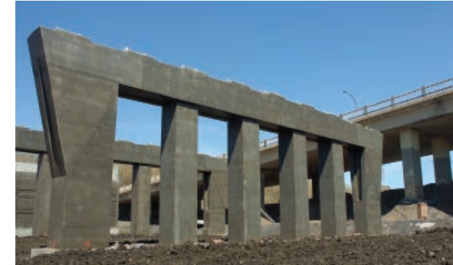
▼ La construction des premiers ponts d'étagement du boulevard Pullman débute dans la cour Turcot. Des pieux sont forés pour la fondation de la structure. (photo : Édith Martin)
