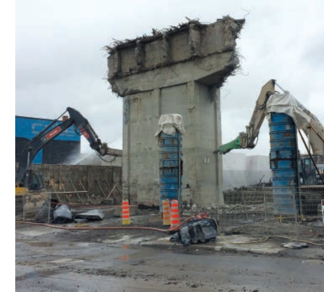
▼ Démantèlement de l'échangeur Angrignon durant l'hiver 2019. Afin de limiter les répercussions pour les usagers de la route ainsi que les commerces et industries du secteur, les travaux de reconstruction ont été réalisés par phases. (photo : Édith Martin)
