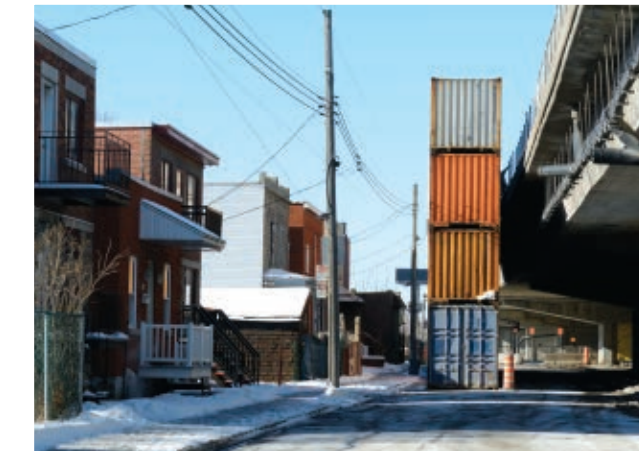
▼ Dans le secteur sud du projet, les structures à démanteler sont situées à quelques mètres seulement des résidences. Un écran de conteneurs est érigé sur la rue De Roberval afin de protéger les citoyens ainsi que la façade des bâtiments. (photo : Édith Martin)
