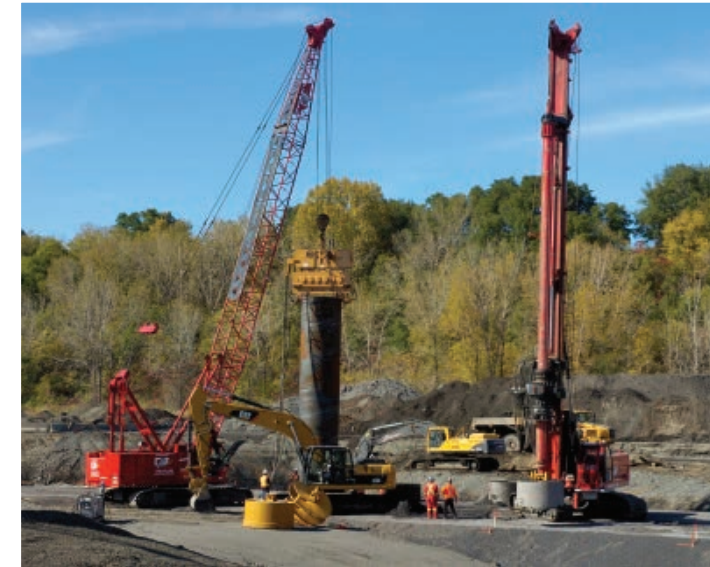
▼ La construction des premiers ponts d'étagement du boulevard Pullman débute dans la cour Turcot. Des pieux sont forés pour la fondation de la structure. (photo : Édith Martin)
