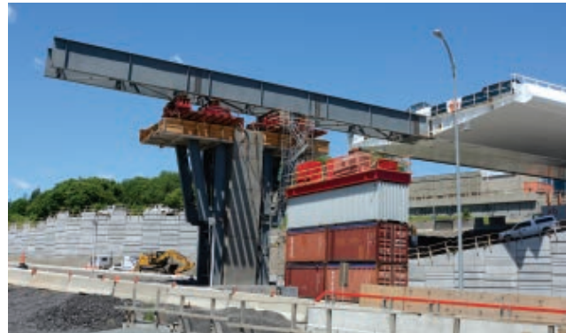
▲ Poussage d'une première section du tablier du pont Saint-Jacques en appui sur le pilier au centre de l'autoroute 15. (photo : Édith Martin) ▼ Mise en service du corridor ferroviaire du Canadien National le 29 août 2018. (photo : Édith Martin)
