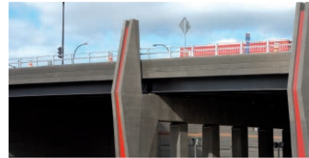
▼ Raccordement du boulevard de Sainte-Anne-de-Bellevue à la rue Notre-Dame Ouest au moyen du troisième pont signature du projet. (photo : Édith Martin)
