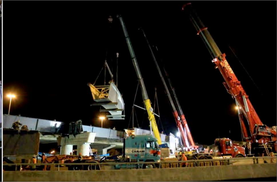
Installation de poutres-caisson, échangeur des Laurentides
