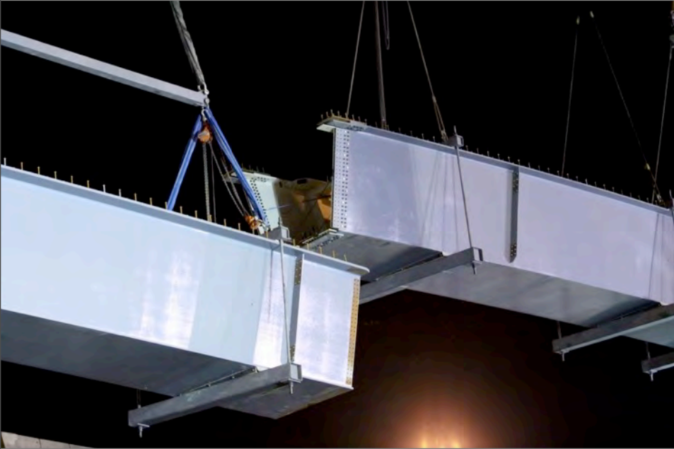
Installation de poutres-caisson, échangeur des Laurentides
