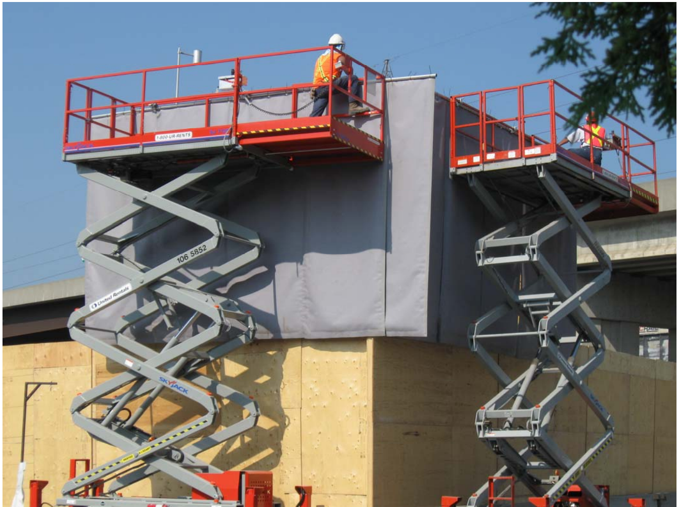
Figure 2 Écran acoustique mobile monté sur une nacelle en cisaille
