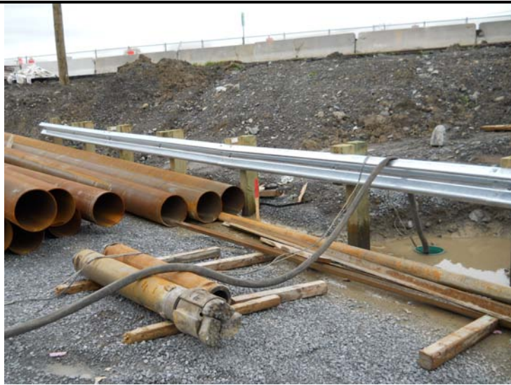
Pompage de l'eau accumulée
